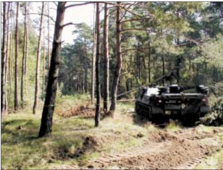
Bergepanzer der Bundeswehr beräumen die Schneise für den fehlenden Deichabschnitt am Treuel
