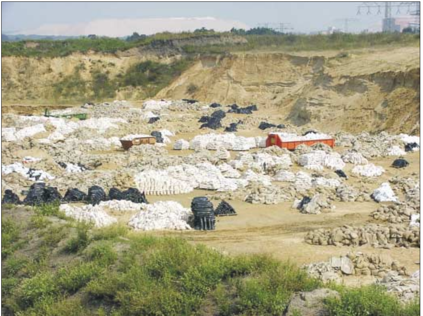
Alle zurückgebauten Sandsäcke in der Kiesgrube Farsleben werden entleert und zur Wiederverwendung gelagert
