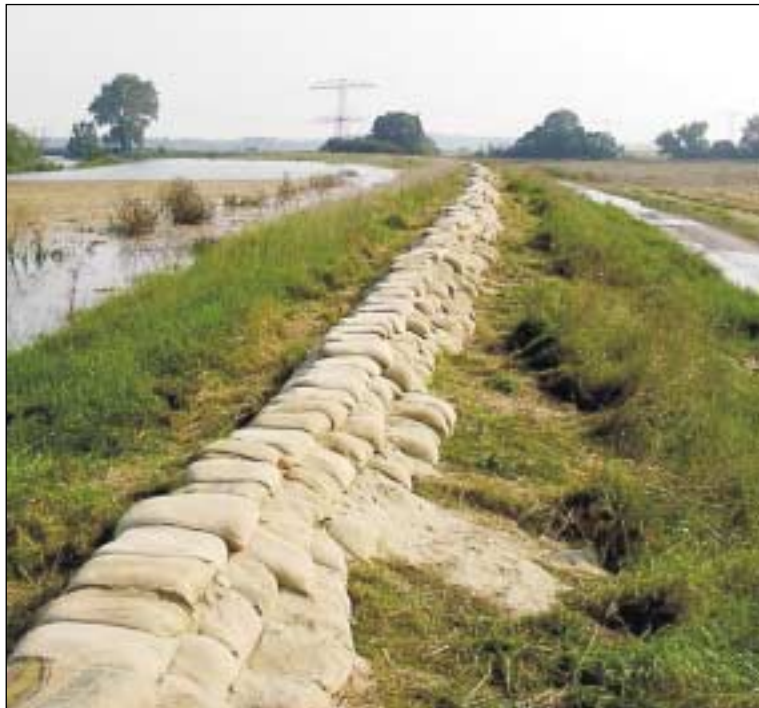
Verbaute Sandsäcke am Ohredeich
