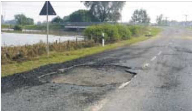
Mit dem Rückgang des Wassers werden die ersten Schäden sichtbar
