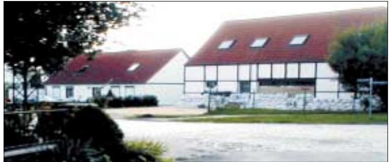
Sandsackverbau in Glindenberg
