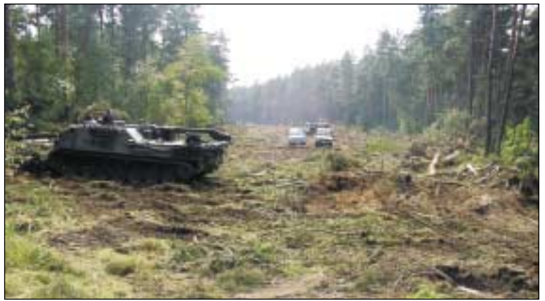
Die Schneise für den neuen Deichabschnitt am Treuel ist fertig
