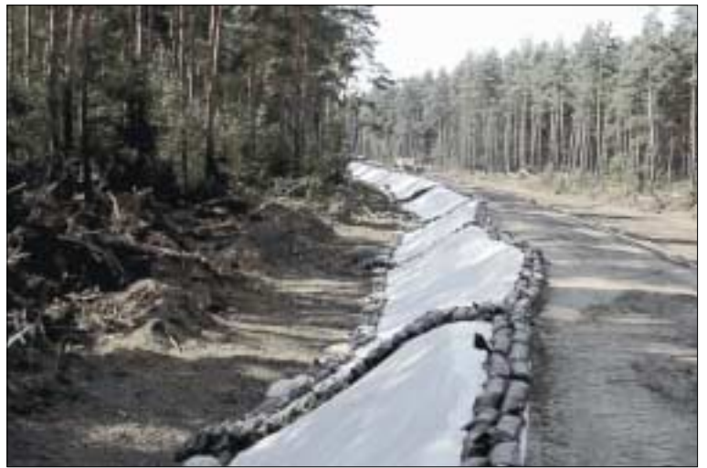
Fertigstellung des Treuel-Deiches
