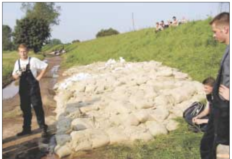
Fachgerechter Verbau von Sickerstellen am Elbedeich
