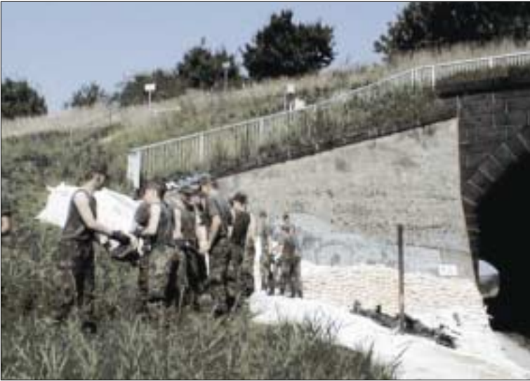
Verbau der Tunnelunterführung der Bahnstrecke Magdeburg - Stendal durch Bundeswehrosoldaten - das Bauwerk ist vor Drückwasser und somit vor dem Einsturz zu schützen
