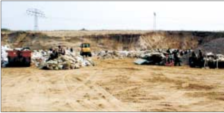
Kiesgrube Farsleben - Ein- und Umlagerung rückgeführter Sandsäcke
