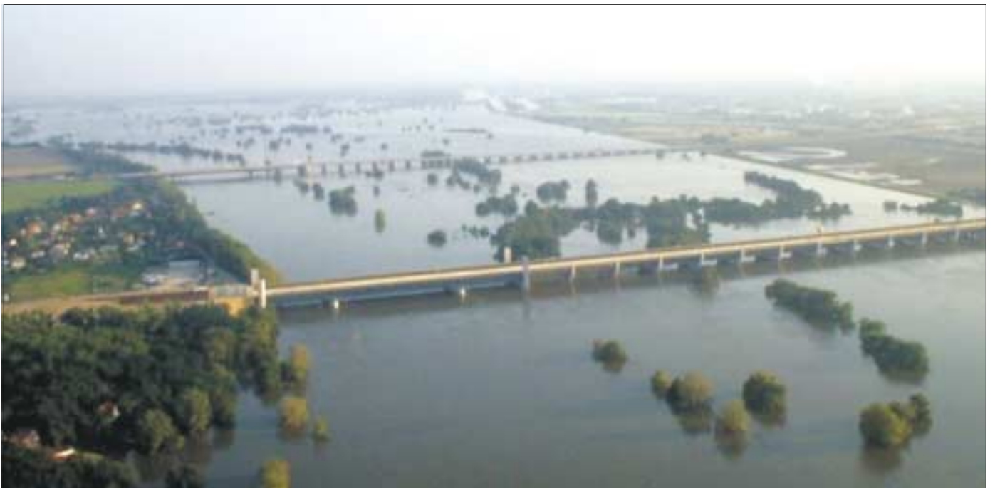
Blick auf die Elbe über die Trogbrücke des Mittellandkanals und die Brücke der A2 aus Richtung Glindenberg
