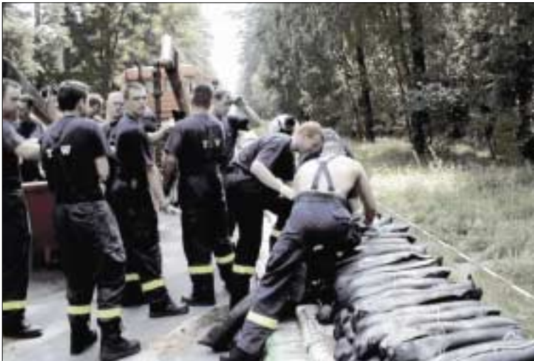
Verbau der Straße Mahlwinkel - Bertingen durch THW
