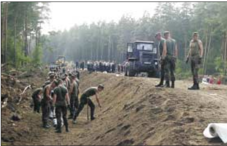
Bauarbeiten am Treuel-Deich durch Bundeswehr und Feuerwehr
