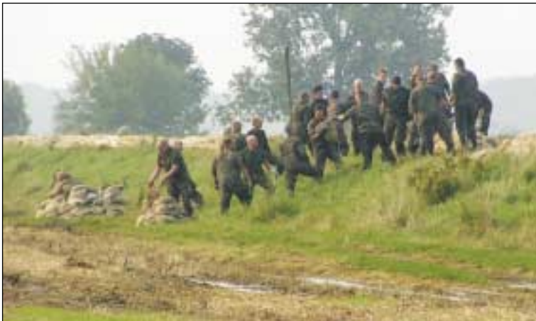
Landseitige Beräumung des Ohredeiches
