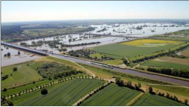
Trog- und Autobahnbrücke
