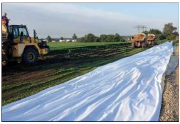
Bau eines Notdeiches mit schwerer Technik...
