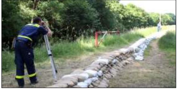
Vermessen des Elbdeiches durch das THW ...
