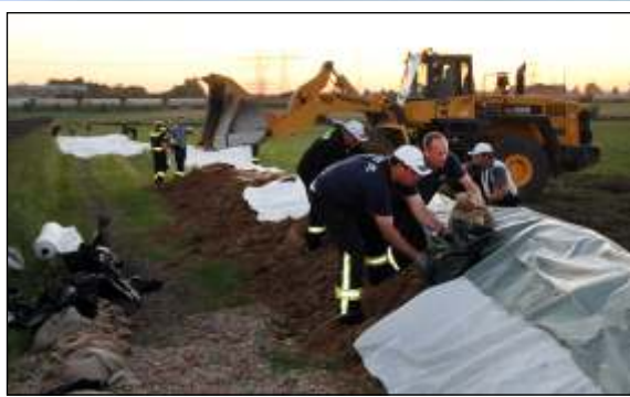
Verbau mit Ratlader (Handwerkerring, Wolmirstedt)
